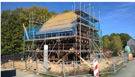
Das Muster-Fachwerkhaus feierte im September 2018 Richtfest Quelle: Freilichtmuseum Hessenpark GmbH
